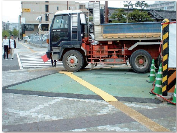
■ 工事現場乗入口
