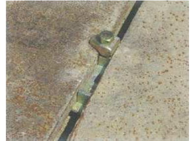
③2枚目の敷鉄板を設置します。
